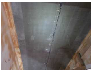
光ファイバーセンサーによる 橋梁モニタリング
