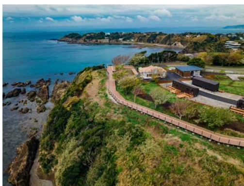
新設ボードウォーク
