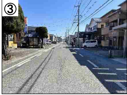
カラー舗装、中央線抹消
