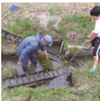
① 水路と水田を結ぶ水田魚道
