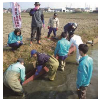
④ 集落総出で魚道を設置
