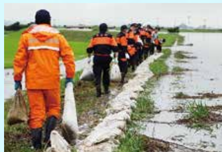
宮城県涌谷町消防団 積み土のう工、月の輪工を実施 (令和4年7月16日~17日: 出来川左岸)
