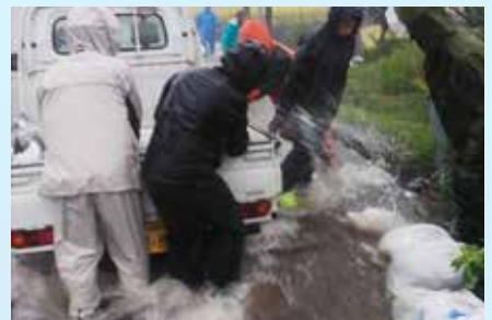
大分県由布市消防団 積み土のう工を実施 (令和4年9月17日~22日: 光永宮川付近)
