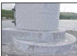
基礎部亀裂補修 (環境遮断)
