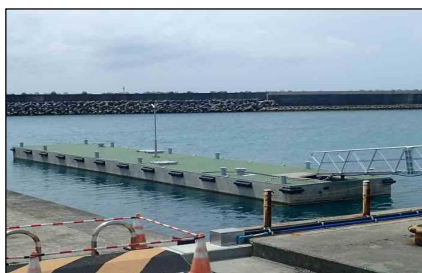
＜係留施設整備＞
