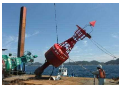
＜灯浮標の設置＞
