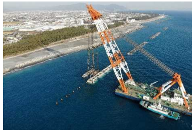
有脚式離岸堤 施工状況
