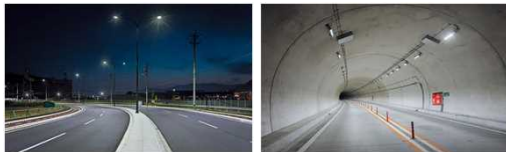
<センサ型、直流給電方式の照明システム>
