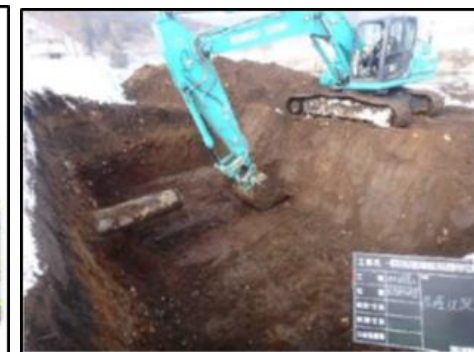
ICT建機による河川土工
