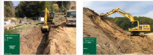
【ICT施工による作業土工施工状況】
