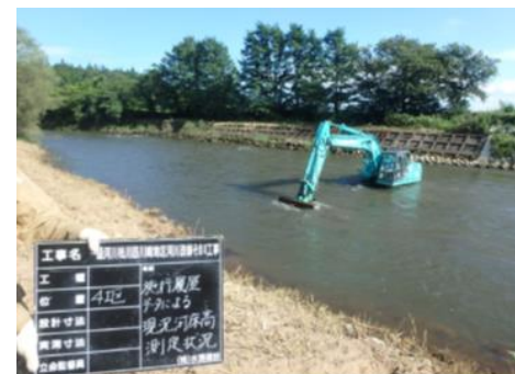
ICT建機(防水型)による河床トレス状況
