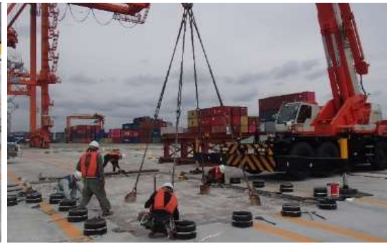
施工性確認試験実施状況(左:床板撤去、右:床板再設置(据付))
