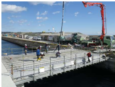
PC ホロー桁の施工状況
