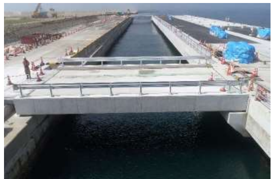
渡橋の架設状況
