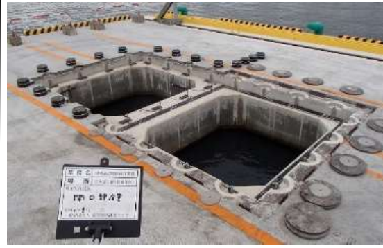
施工性確認試験実施状況(左:床板撤去、右:床板再設置(据付))
