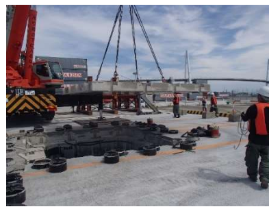
リプレイサブル栈橋の施工状況
