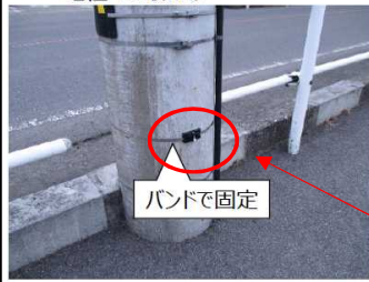
電柱への取付け
