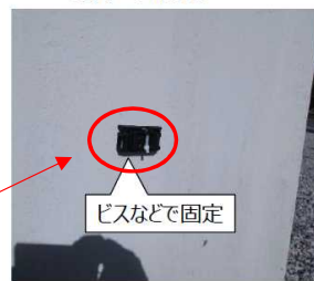
壁面への取付け
