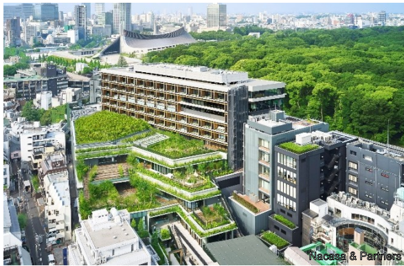
上空から見た建物全景 背後は明治神宮の社
