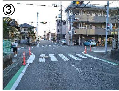
歩行空間整備(カラー舗装)
