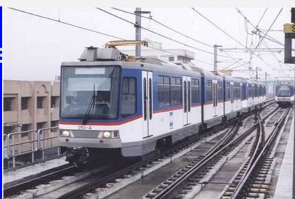
マニラ首都圏を走行するマニラ MRT3号線(改修工事後)
