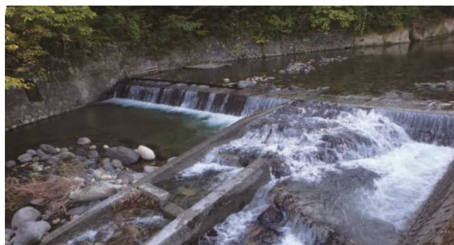
②間伐材等を利用した手づくりの魚道を設置
