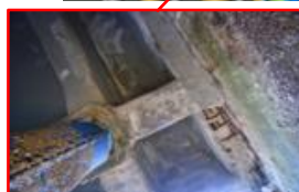
栈橋下部の状況
