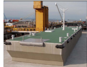
＜係留施設整備＞
