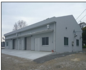
＜船艇用品庫整備＞
