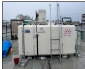
＜燃料タンク整備＞
