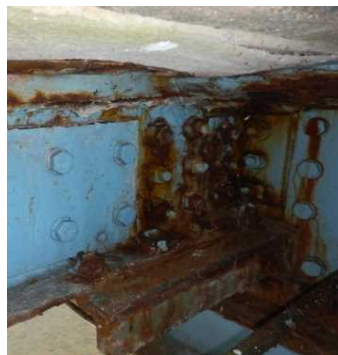
縦桁の腐食
