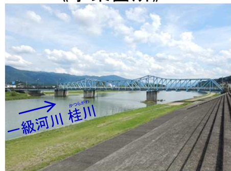
全景（写真①）
