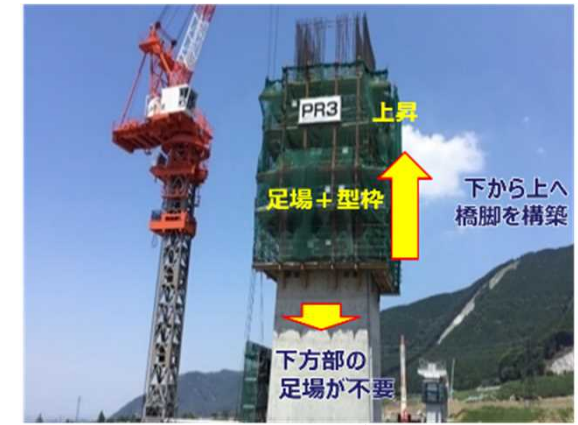
ACSセルフクライミングシステム工法
