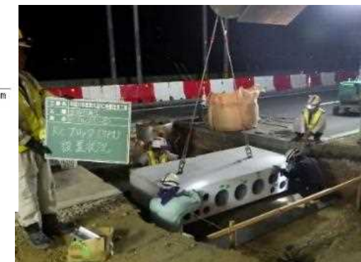
今回取組施工状況写真
