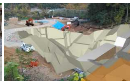
【掘削・床掘AR】
