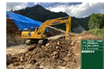
擁壁基礎の床堀(丁張りなし)
