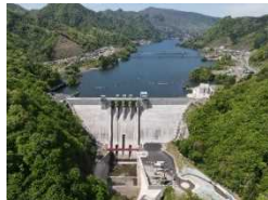
ハツ場ダム（関東地方整備局）
