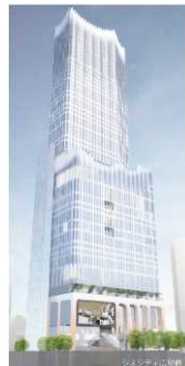
歌舞伎町一丁目地区 国家戦略都市計画 建築物等整備事業「メゾ」P-5 （東京都都市整備局H P）
