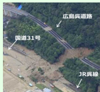
H30災害を受け広島呉道路4車線化
