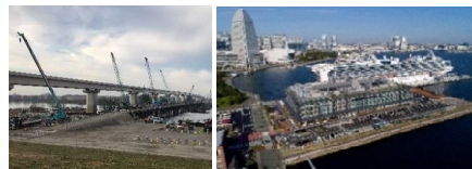
圏央道4車線化推進 （関東地方整備局）
