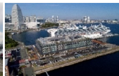
横浜港・新港ふ頭 客船ターミナル施設 （横浜市提供）
