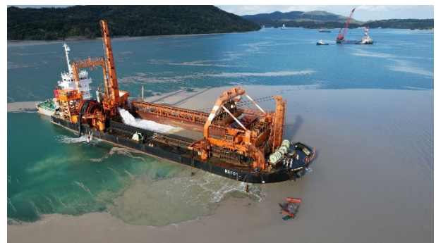
[砂利採取運搬船による軽石の除去状況]
