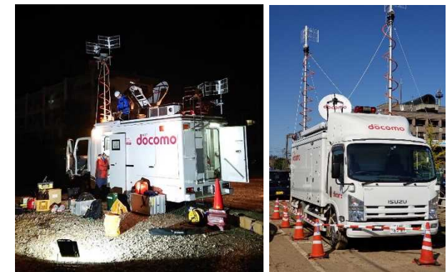
衛星通信による基地局の設置(NTTドコモHPより)
