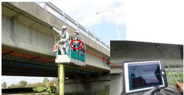
新技術を活用した点検イメージ (打音点検)
