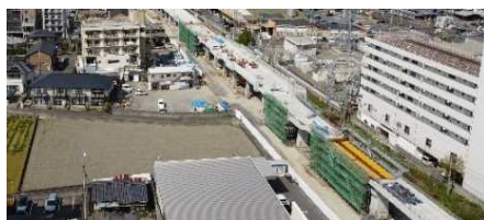
【高架区間工事状況】
