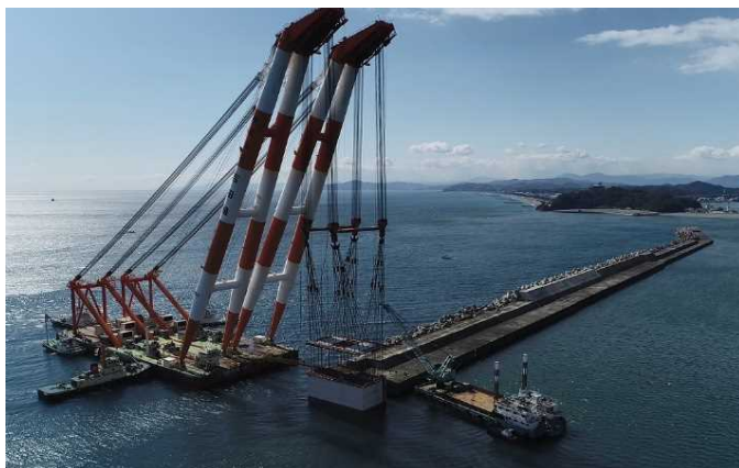
【ケーソン据付状況】
