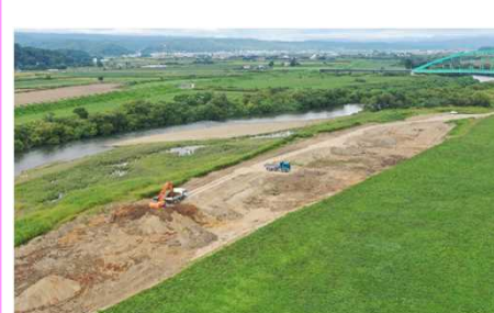
氾濫をできるだけ防ぐ河道掘削
