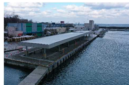
屋根付き岸壁（増毛港）
