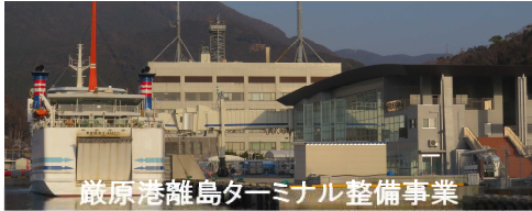
厳原港離島ターミナル整備事業 出典)九州地方整備局
