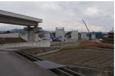
【南国安芸道路 進捗状況】
