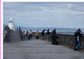
▲青森港北防波堤(限定開放)
