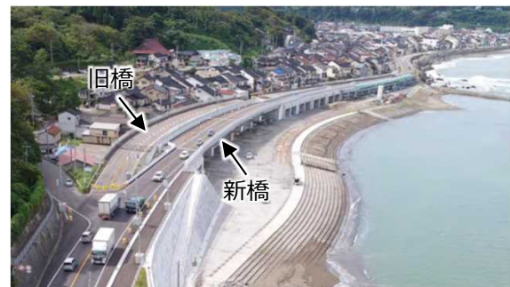
【一般国道8号弁天大橋の橋梁架替】
