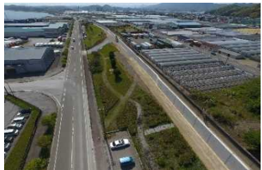
【高知港海岸 進捗状況】
