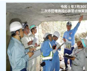
〈直営点検の実習風景〉
