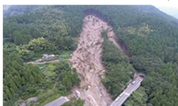
図2 寸断された高速道路
