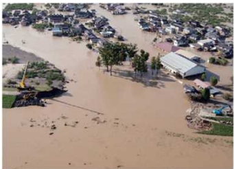
令和元年東日本台風で発生した千曲川の堤防決壊
