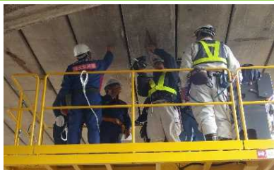
天大橋(国・市による合同診断) 出典)九州地方整備局
