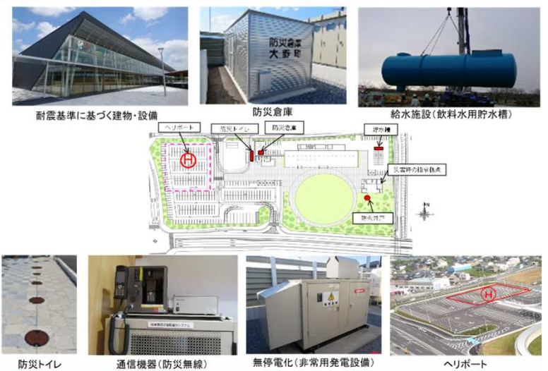
耐震基準に基づく建物・設備 防災倉庫 給水施設(飲料水用貯水水槽) ヘルポート 防災トイレ 通信機器(防災無線) 無停電化(非常用発電設備) ヘルポート
