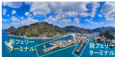
【八幡浜港工事状況】
