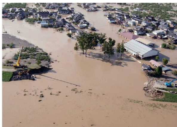
図11 令和元年東日本台風で発生した千曲川の堤防決壊（長野市穂保地区）
