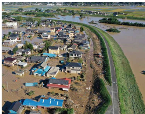
堤防が決壊した都幾川(埼玉県東松山市)
