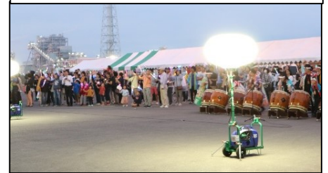
照明設備【仙台塩釜港】
