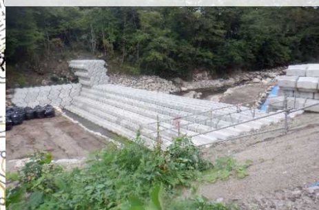
仮設ブロック堰堤 (設置イメージ)
