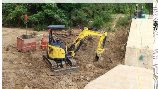
既設砂防堰堤の除石 (施工イメージ)
