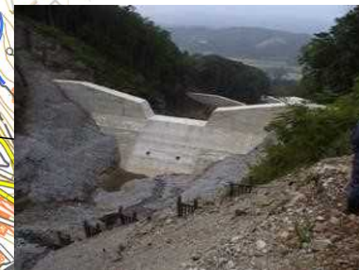
砂防堰堤の新設 (設置イメージ)
