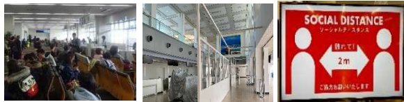
待合室等の改修
