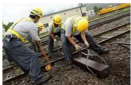
鉄道施設の修繕
