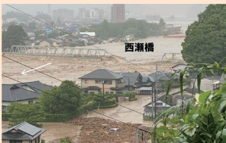
図表2-2-7 球磨川における西瀬橋の流出
