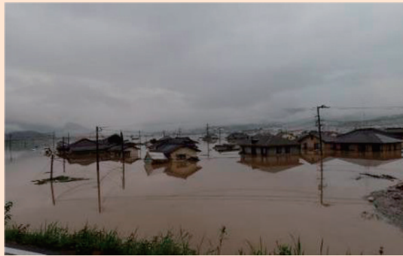
図表2-2-2 岡山県（倉敷市真備町）の浸水被害
