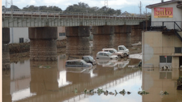
図表2-2-5 福島県（郡山市）の浸水被害
