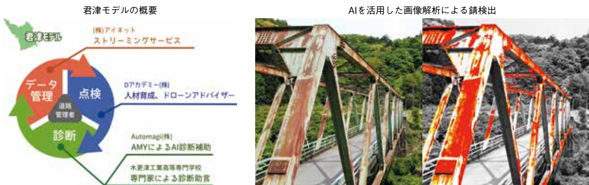
図表1-3-17 君津モデルの概要及びAIを活用した画像解析による錆検出
