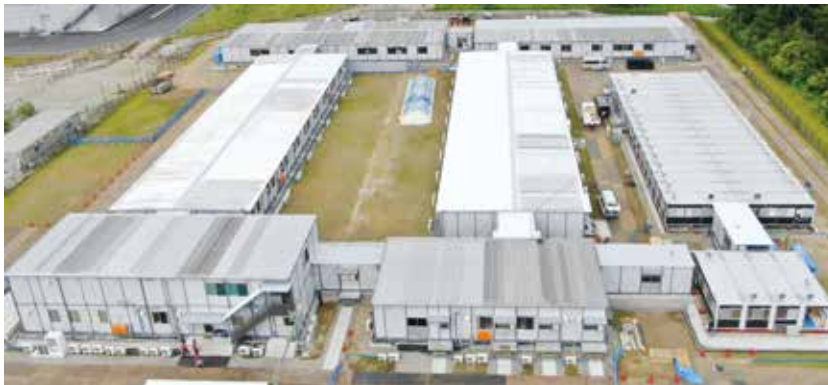
図表1-1-9 仮設医療施設の外観
