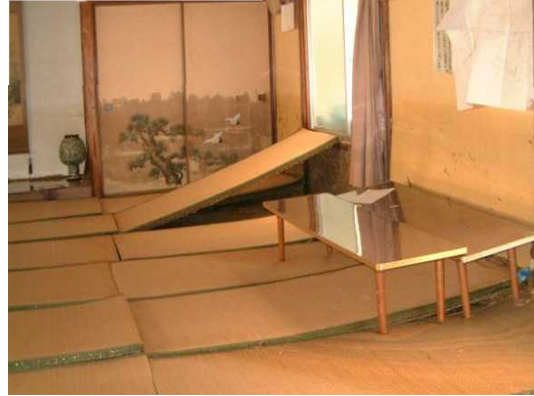
図 1-4 床上浸水による被災例 (資料／倉敷市「災害廃棄物処理計画について」)
