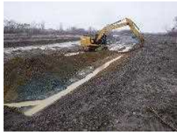
河道掘削 (石狩川水系、北海道開発局)
