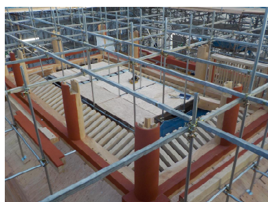
南門の復元整備の状況
