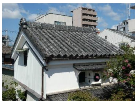
歴史的建造物の修理・修景工事を支援
