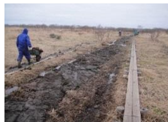
水抜き水路の埋め戻し
