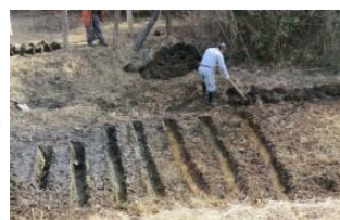
土砂堆積部分の浚渫
