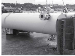
国土交通大臣賞 仙台塩釜港西ふ頭棧橋・観光棧橋災害復旧事業 宮城県土木部港湾課
