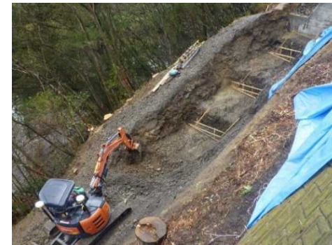
ICT建機による掘削作業
