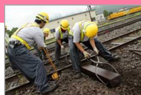
▲鉄道施設の修繕
