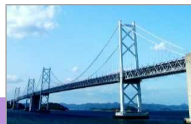
▲本四連絡橋(瀬戸大橋)
