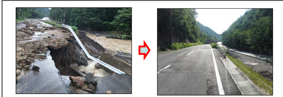
擁壁工を施工し道路流出対策を行う。 （事業近隣箇所での整備効果）
