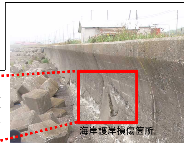
損傷箇所拡大
