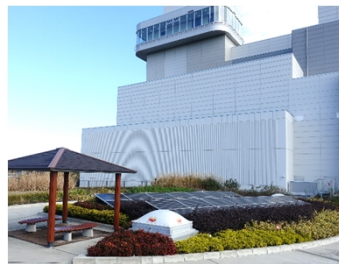
屋上庭園の様子
