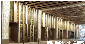
建物の間にある大宝寺通りに設けられた壁面緑化。常緑の植栽（オオイトビカツラ等）によるストライプの植栽配置。
