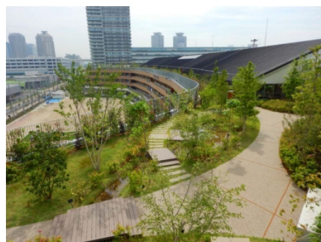
令和元年に施工された屋上緑化の例 江東区立有明西学園
