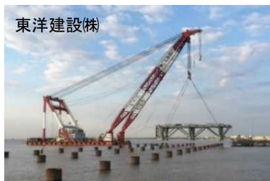
ジャケット施工の様子(ティラワ港)
