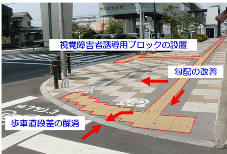
道路のバリアフリー化整備事例
