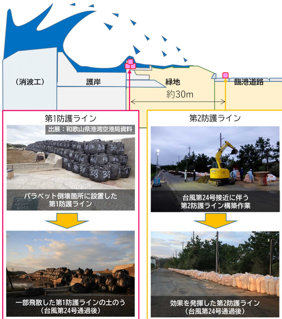
図7 和歌山下津港での土のう配置例及びその効果
