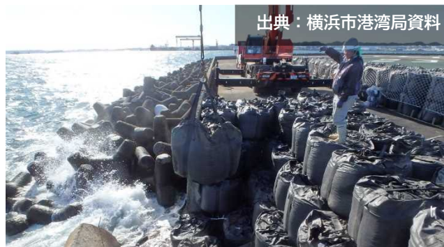
図 12 和歌山下津港での土のうの設置工事の状況
