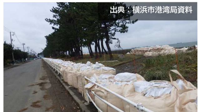
図11 土のうの結束等（左：結束作業／右：ガードレール沿いに設置した土のう）
