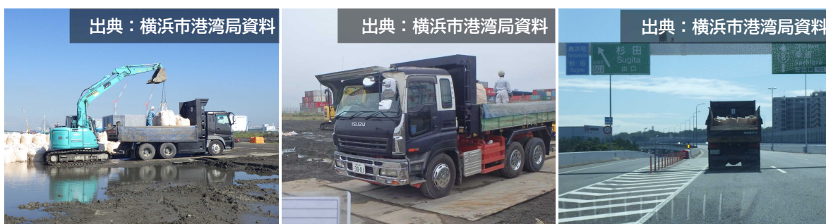
図6 10tダンプでの土のう運搬（横浜港の例）
