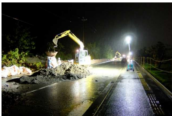
図 12 和歌山下津港での土のうの設置工事の状況
