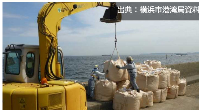
図 13 横浜港での土のうの設置工事の状況 (上段：被災護岸応急復旧及び下段左／下段右：交通誘導員等)
