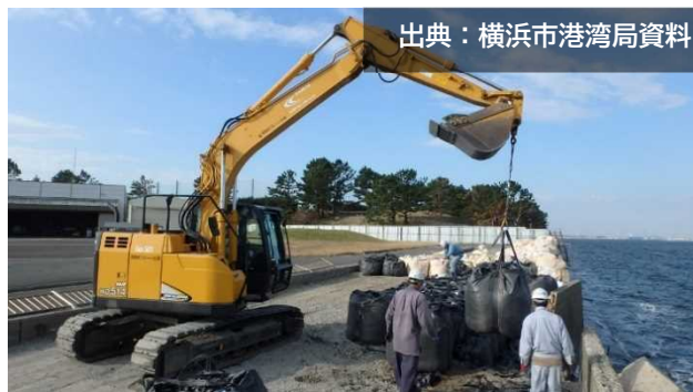
図 12 和歌山下津港での土のうの設置工事の状況
