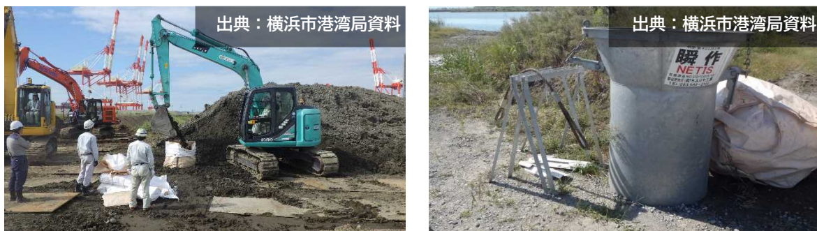
図5 土のうの製作状況（横浜港の例）（右：中詰材充填／左：充填で使用した機材）
