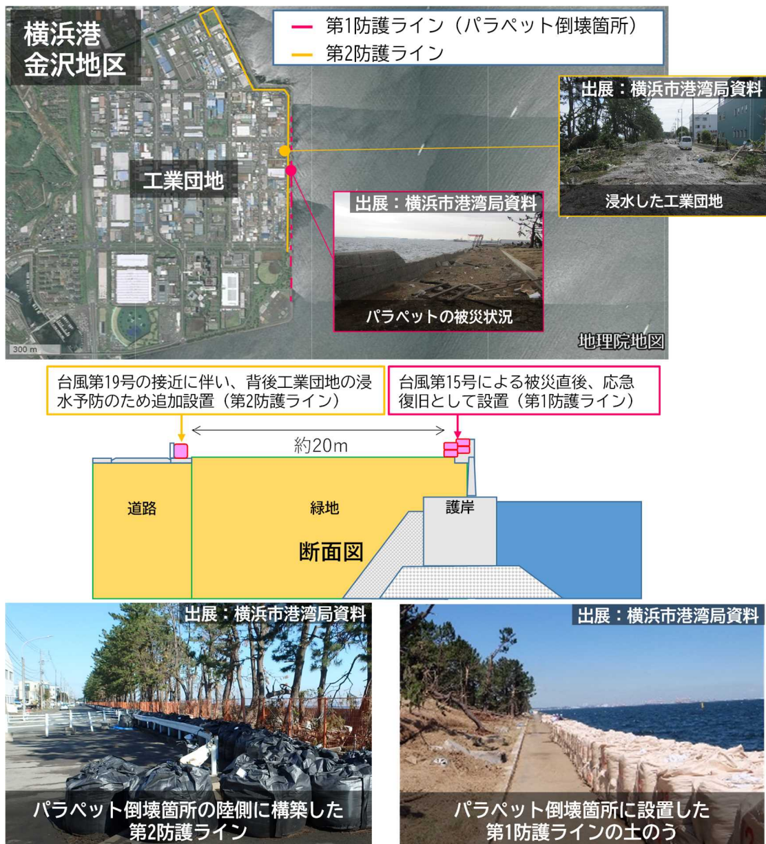
図2 横浜港での土のう設置状況
