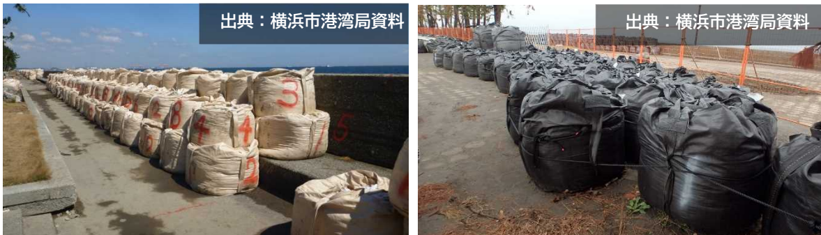
図4 土のう袋（横浜港の例）（左：フレキシブル・コンテナバッグ／右：耐候性土のう袋）
