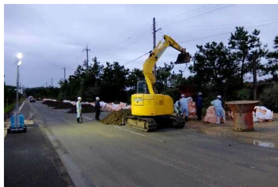
図 12 和歌山下津港での土のうの設置工事の状況
