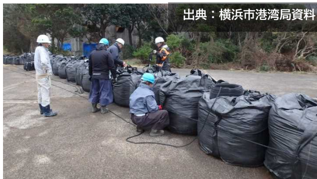
図11 土のうの結束等（左：結束作業／右：ガードレール沿いに設置した土のう）
