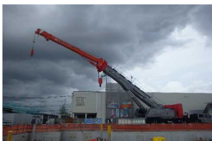
ラフタークレーンによる施工
