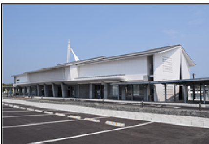
【代表施設】口之津港ターミナルビル
