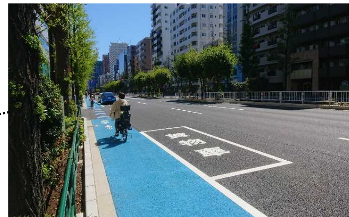
都道301号（白山通り） ※自転車通行帯の車道側に停車帯を設置
