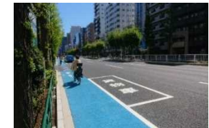
<自転車専用通行帯(白山通り)>
