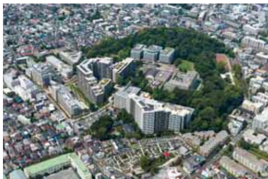
当地区は、中野区北端、練馬区との区界に位置し、江古田の森公園に隣接している。リング状の緑地帯が形成されている。
