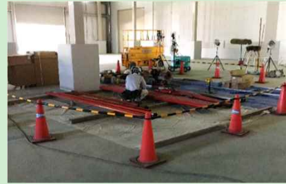
工事エリアの区画を設定して作業
