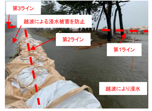
土嚢を3列に配置し浸水被害を防止(10月12日撮影)
